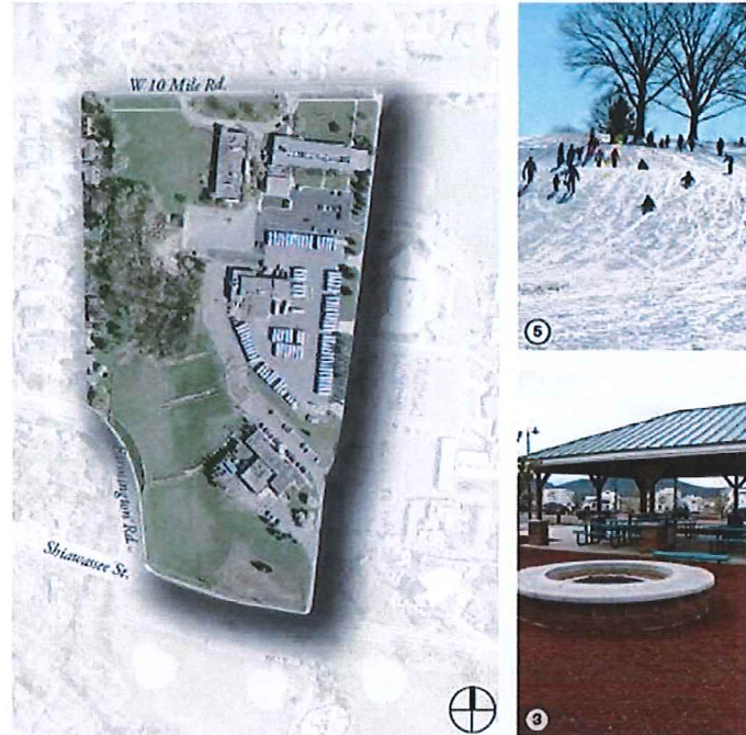
FIGURE 3.13: SUBAREA D - EXISTING CONDITION
